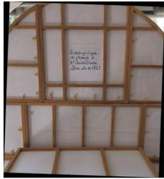
El ensamblado se realiza mediante clavijas de madera.
